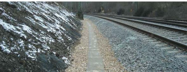
Fertige Porosit-Entwässerung als Randweg
