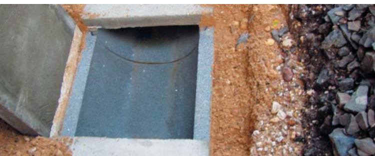
Geöffnetes Drän-Versickerungssystem
