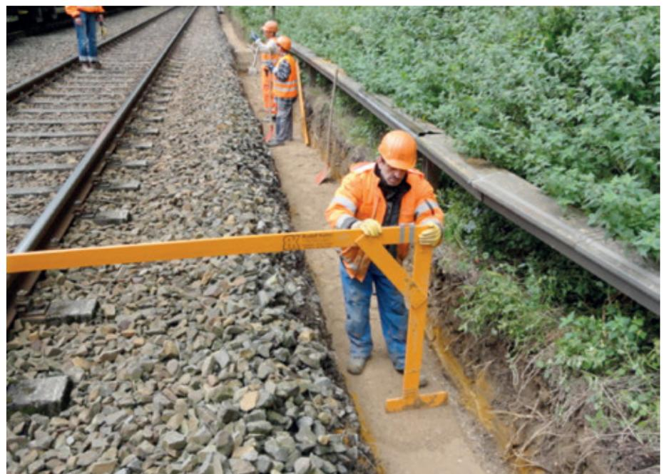
Abb. 6: Herstellung des Sickergrabens am Schotterfuß, Variante 3
