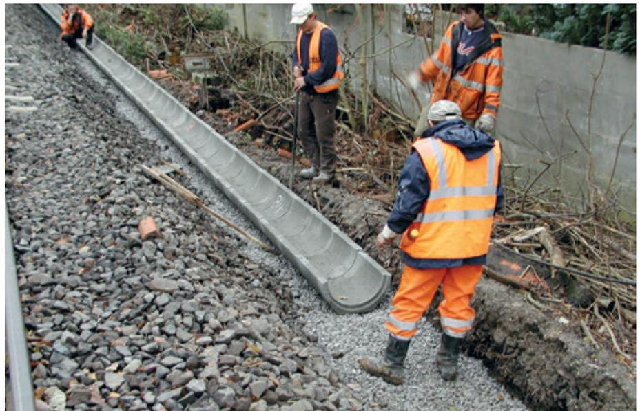
**Abb. 9:** Einbau der Porosit-Halbschalen. Das filterstabile Korngemisch soll einerseits in seiner Eigenschaft Filteraufgaben erfüllen und andererseits einer einwandfreien Verlegung der Fertigteile dienen. Das Abziehen des Verlegeplanums für die Fertigteile kann genauestens hergestellt werden (Mittels einer angefertigten Lehre; gemessener Abstand und Höhe von SO bei Sohlgefälle = Gleisgradiente).
