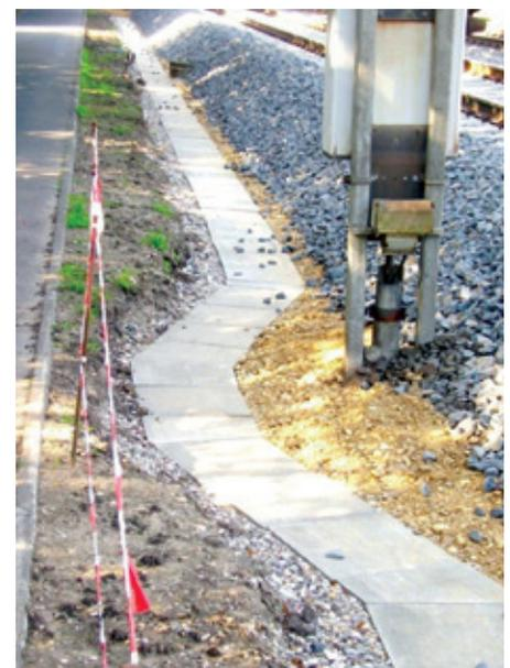
**Abb. 11:** Durch die Länge der Einzelfertigteile von  $l = 50,0$  cm können in der Entwässerungstrasse stehende Hindernisse leicht umgangen werden.
