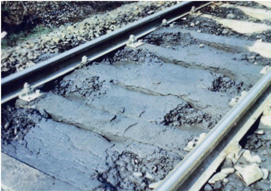
Abb. 1: Ergebnisse einer unzureichenden Entwässerung der Bahnstrecke
