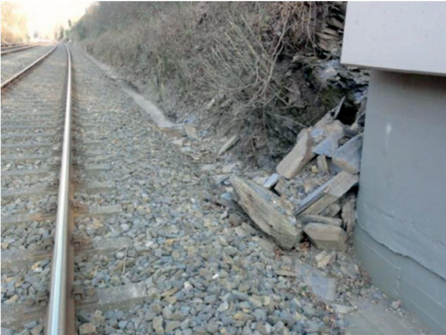
Abb. 7: Erosionen im Anschnitt. Die Funktion der Entwässerung bleibt voll erhalten.
