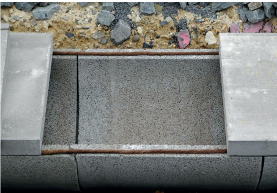
Abb. 8: Die Abdeckung gewährleistet an jeder Stelle eine einfache Kontrolle und Reinigung des Entwässerungssystems.
