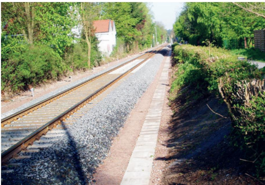
**Abb. 10:** Nach Auflegen der Abdeckung erfolgt eine seitliche Verfüllung der Porosit-Halbschalen mit dem gleichen Kies-/Sandgemisch Betonkies (B32, DIN 1045) wie für die Sohle.
