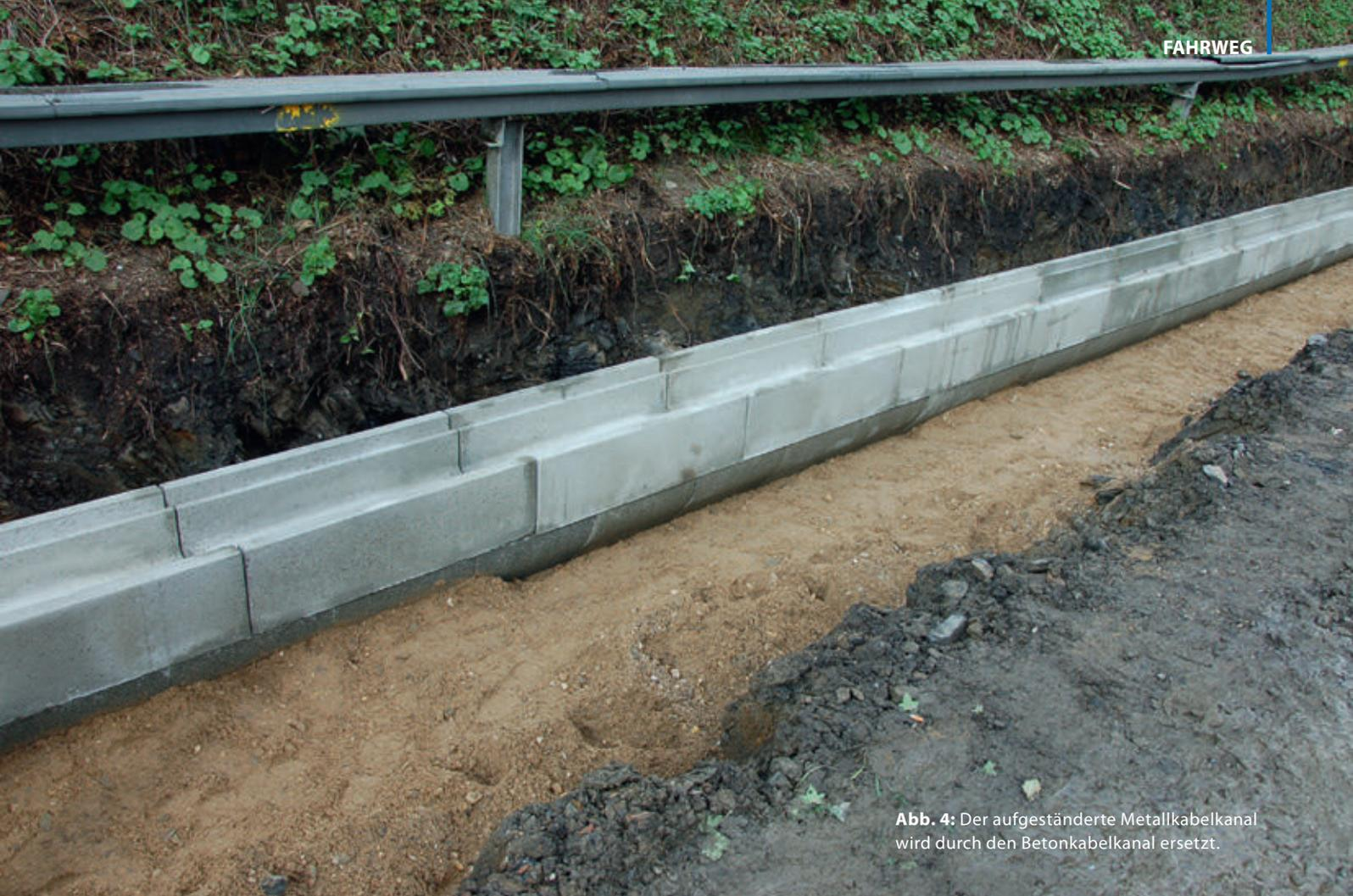
Abb. 4: Der aufgeständerte Metallkabelkanal wird durch den Betonkabelkanal ersetzt.
