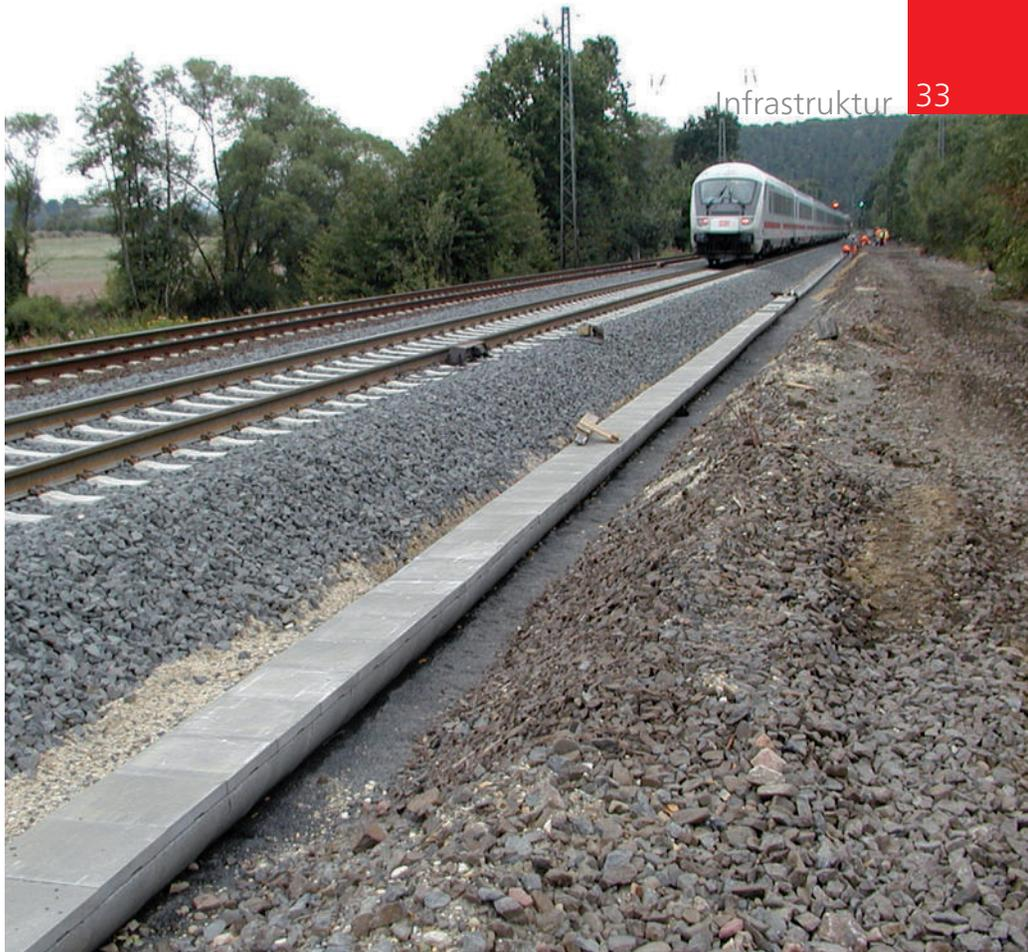
*Ein sanierter Gleisabschnitt, bei dem der Randwegbereich mit einem Drän-Versickerungssystem neu gestaltet wurde.*
