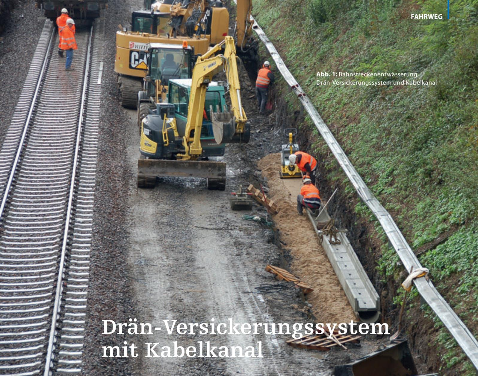
Abb. 1: Bahnstreckenentwässerung, Drän-Versickerungssystem und Kabelkanal
