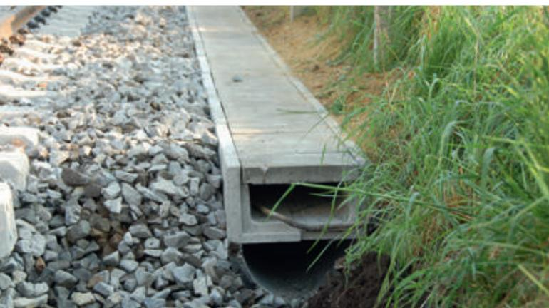
**Abb. 6:** Drän-Versickerungssystem mit Kabelkanal, Bauausführung
