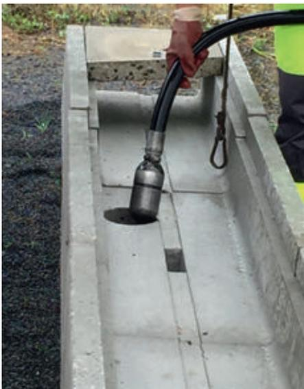
**Abb. 7:** Drän-Versickerungssystem mit Kabelkanal, Reinigung der Halbschale
