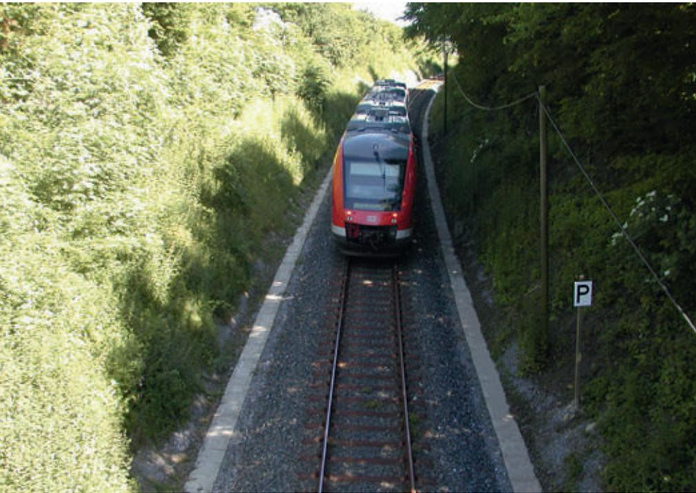
Abb. 2: Streckenentwässerung mit Drän-Versickerungssystem
