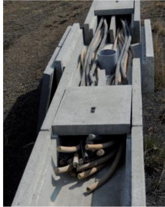
**Möglichkeiten für den Zugang zur Halbschale: Umlenkstelle (links) mit einer Aufsatzöffnung und größerer Kabelkanal mit einem Aufsatzrohr in der Mitte (rechts).**
