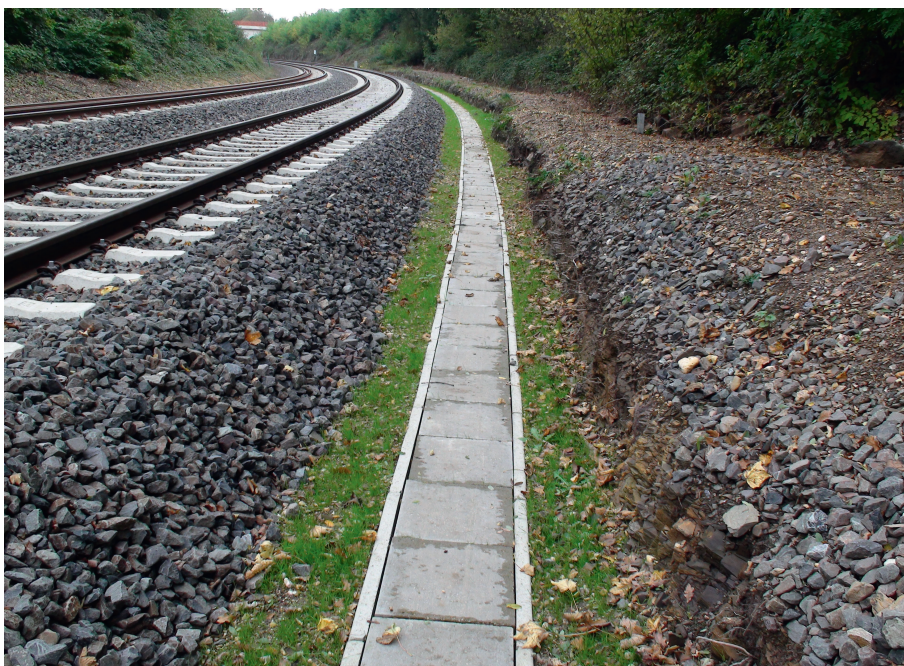
Abb. 11: Kombinierte Entwässerungsanlage, Randweg, belebter Boden
